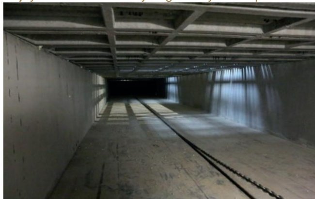
Zbiornik na obornik z widocznym łańcuchem
