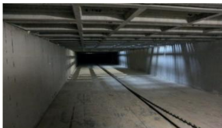
Fossa di raccolta delle feci. In evidenza la catena di trascinamento del raschiatore
