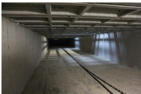
Fosa de recolección de estiércol con la cadena del rascador visible
